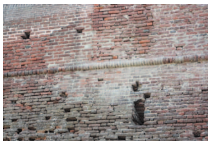
Cordolo e scarpa sottostante
