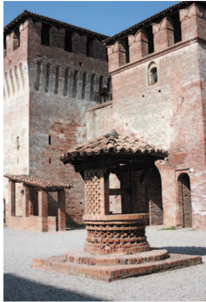
Pozzo nel cortile
