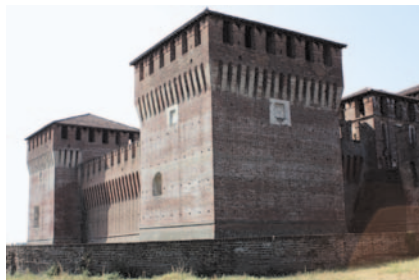
Veduta laterale torri d'angolo
