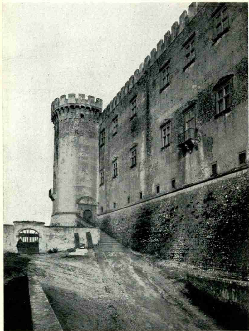
Il castello degli Orsini a Bracciano: fiancata e torre.
