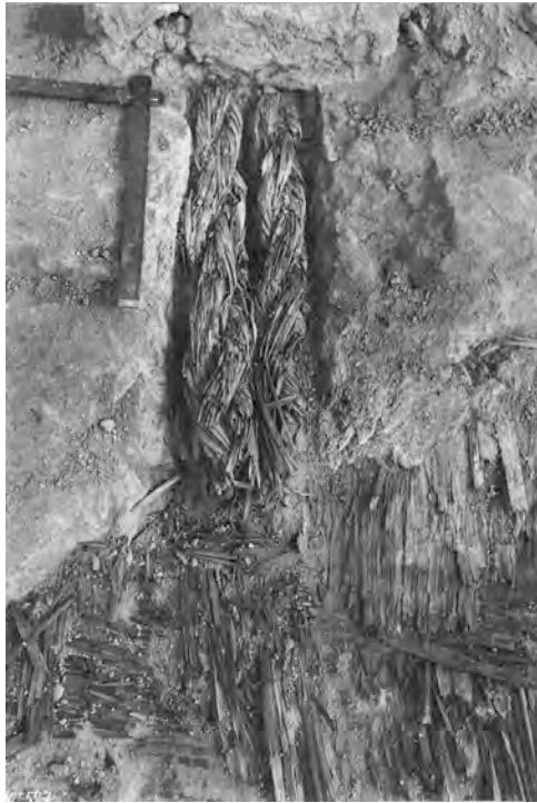
Abb. 3.38: Schilfrohlage und Doppeltau aus gedrehtem Schilf im Lehmziegelmassiv der Zikkurrat des Urnammu im Eannabezirk von Uruk/Ur III-Zeit. Photo: DAI, Orient-Abteilung, Photo-Nr. W000597.
