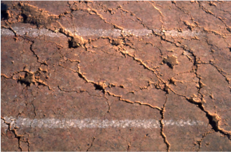
Abb. 2.20: Çayönü, Detail des rot eingefärbten und mit weißen Streifen gegliederten Kalkestrichfußbodens, Detail von Abb. 2.19, (Foto: W. Schnuchel/Universität Karlsruhe).
