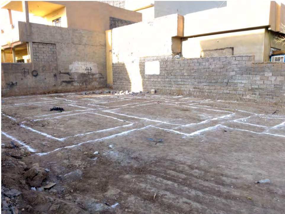
Abb. 2.25: Erbil, Autonome Region Kurdistan, Irak, heutiges Beispiel für die Übertragung eines geplanten Grundrisses auf den Baugrund mittels ausgestreutem Kalk (Foto: A.-M. Arera 2012).
