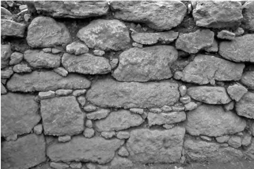
Abb. 2.8: Göbekli Tepe, Anlage C frühneolithische Bruchsteinmauer mit ‚Auswicklungen‘ durch kleine Füllsteine (Foto: D. Kurapkat/DAI 2000).
