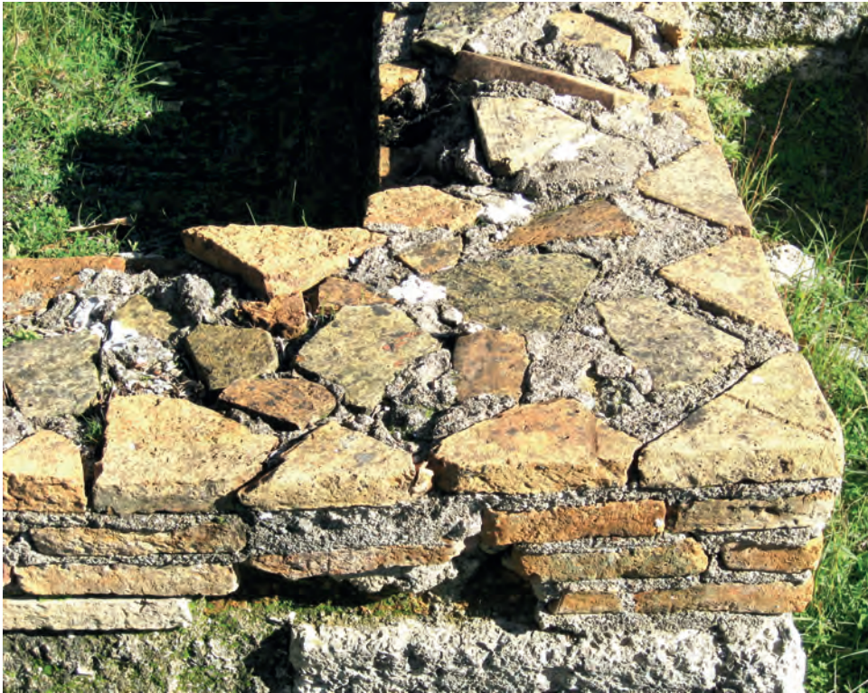
Abb. 3.11: Opus testaceum, Aufbau. Leonidaion in Olympia, Restrukturierung aus dem 2. Jh. n. Chr. Äußere Ziegel diagonal gebrochen. Mauerkerne nicht mit caementitium Füllung, sondern grobes Ziegelmauerwerk (W. Osthues).
