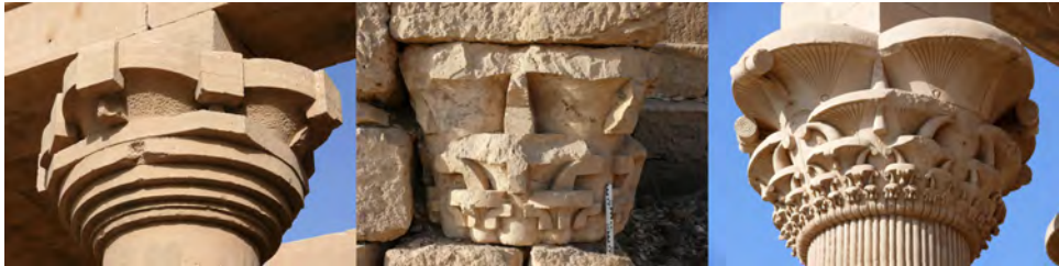
Abb. 1.24: Links: Unfertiges Lilienkapitell in Philae. Außer an der obersten von vier Reihen ist lediglich die horizontale Gliederung erkennbar; der Zustand entspricht also der Zeichnung in Abb. 1.7. Östlicher Dromos, um die Zeitenwende. Mitte: Dieses unvollendete, dreireihige Kapitell aus griechisch-römischer Zeit wurde in Athribis im Kernmauerwerk verbaut. Sein Zustand entspricht dem Modell in Abb. 1.9. Rechts: Vollendetes, fünfreihiges Lilienkapitell in Philae, großer Kiosk, Kaiserzeit (Fotos: U. Fauerbach).
