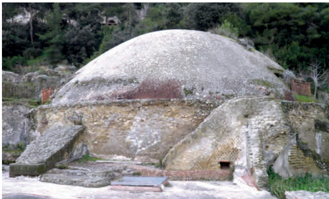
Abb. 3.28: Baiae, Mercurtempel. Links im Bild Strebepfeilder (W. Osthues).
