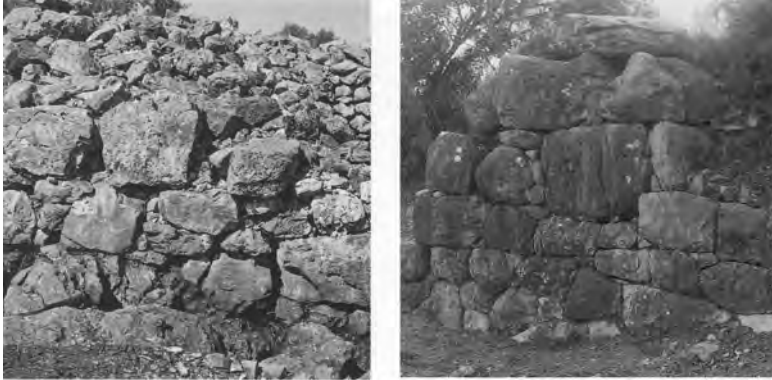
Abb. 2.18: Bruchstein-Mauerwerk (Müller-Wiener 1988, Abb. 30).
