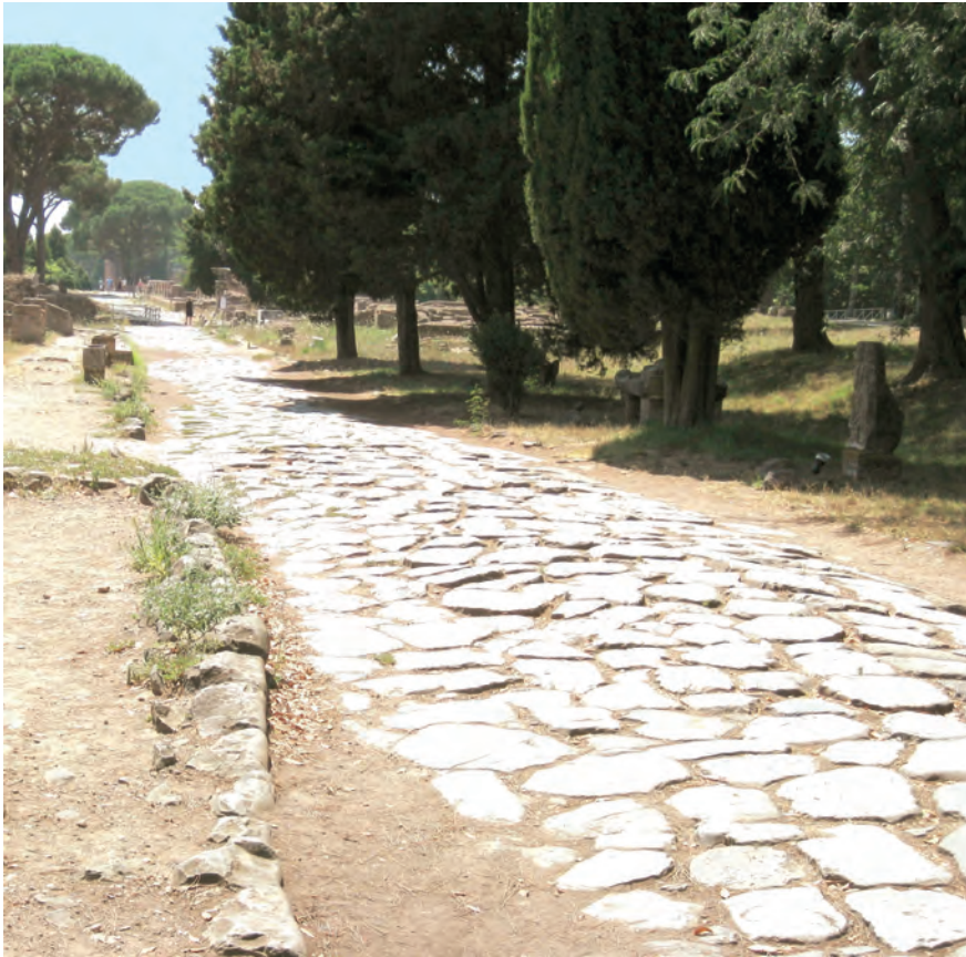
Abb. 3.32: Via Ostiense. Römisches Strassenpflaster (W. Osthues).
