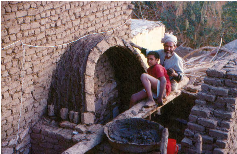
Abb. 1.30: Herstellung eines Kufgewölbes auf Elephantine. Die traditionelle Technik wird auf der Baustelle von Generation zu Generation weitergegeben (Foto: D. Kurapkat 2001).
