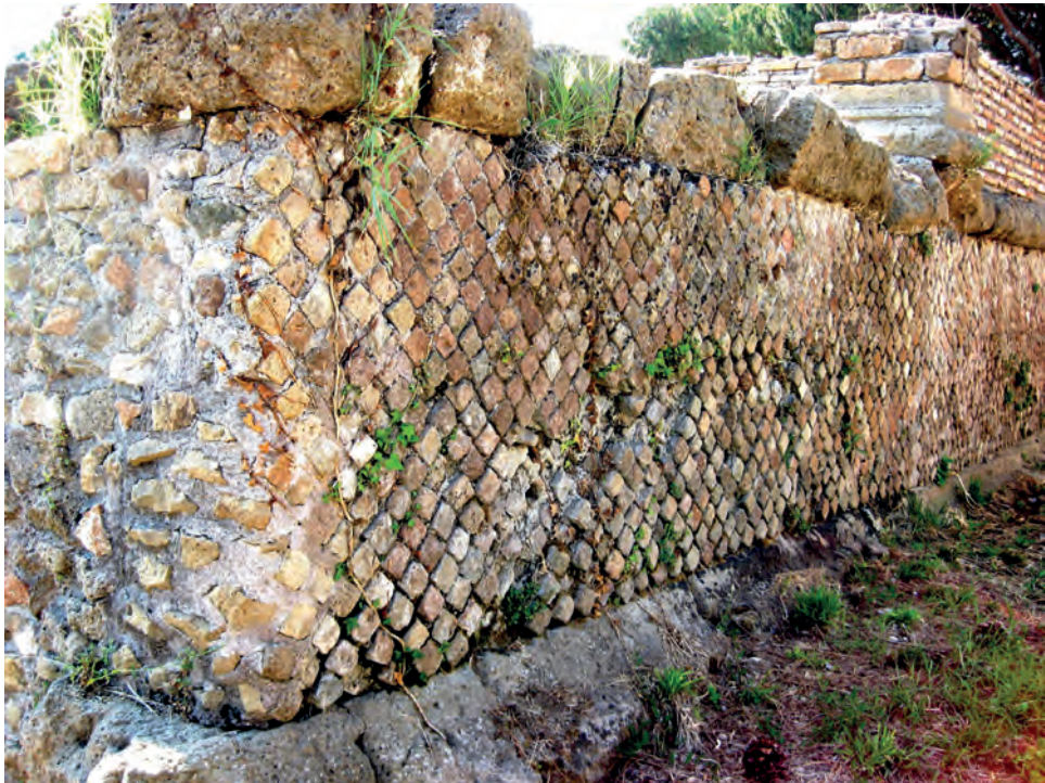
Abb. 3.9: Opus reticulatum an Unterbau des ‚tempio repubblicano‘ in Ostia, Mitte 1. Jh. v. Chr. Links im Bild der Mauer Kern aus caementitium (W. Osthuess).
