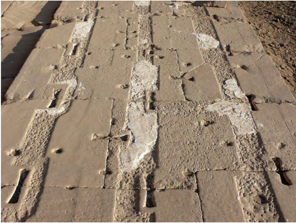
Abb. 1.27: Mauerwerk der Tempelumfassungsmauer in Dendera, 1. Jahrhundert n. Chr. Die obere Steinlage fehlt; die Mörtelbetten, in denen Teils noch Mörtel zu erkennen ist, sind sorgfältig um die schwalbenschwanzförmigen Klammerlöcher herumgeführt. Die kleineren Löcher dienen zum Ansetzen von Hebeln für die folgende Steinlage (Foto: U. Fauerbach).
