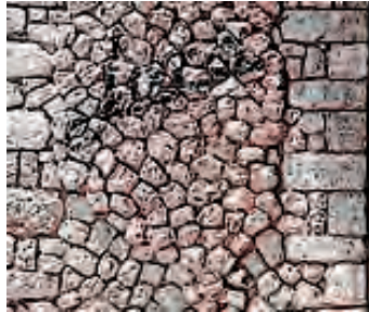
Abb. 3.8: Opus incertum am Unterbau des Tempels des Jupiter Anxur von Tarracina, heute Terracina (W. Osthues).
