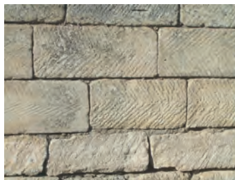
Abb. 3.10: Opus quadratum Kalkstein, Flächen gespitzt (W. Osthues).
