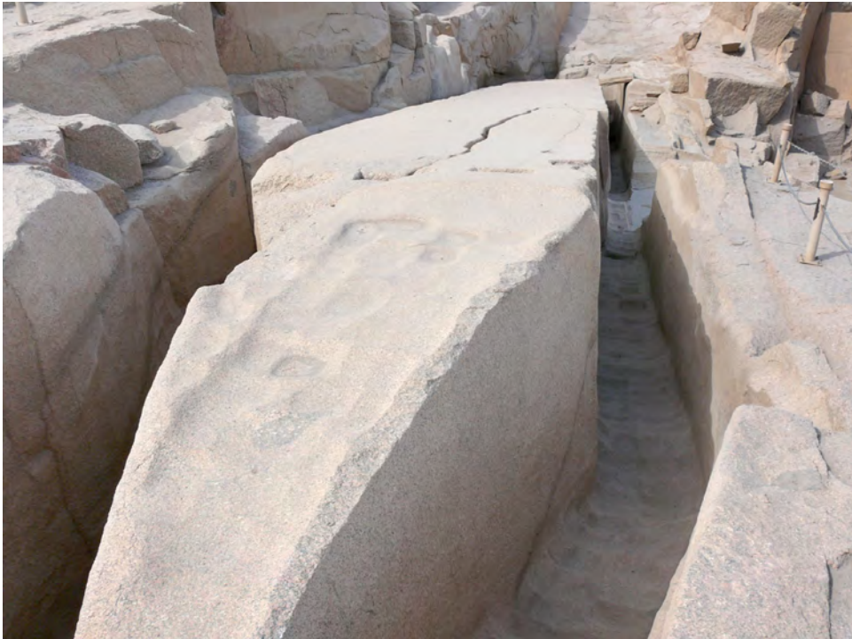
Abb. 1.23: Unvollendeter Obelisk im Granitsteinbruch von Assuan. Die gerundeten Vertiefungen sind Schlagspuren von Dioritwerkzeugen. Die Schrotgräben rechts und links des Obelisken boten jeweils einer Reihe von Arbeitern Platz (Foto: U. Fauerbach).
