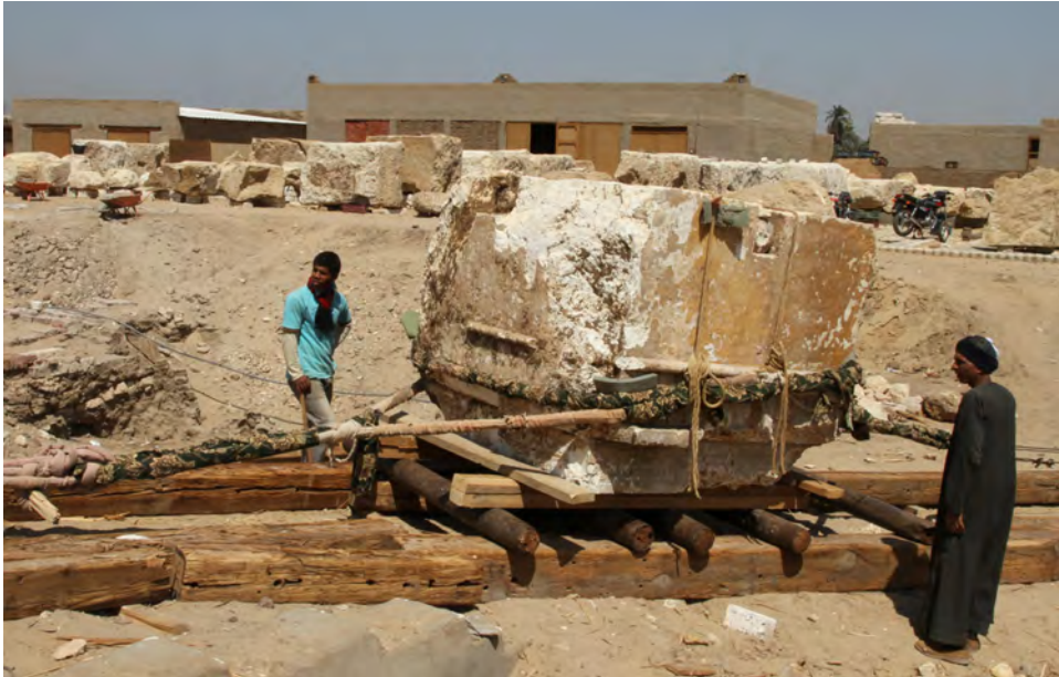
Abb. 1.21: Steintransport in Athribis unter Leitung von Rais Gamal Ghasab, 2012, mit einer Seilwinde (nicht im Bild). Der mehrere Tonnen wiegende Block ist auf eisenummantelten Rollen gelagert, die sich auf Holzschienen drehen. Das Holz ist hohem Verschleiß ausgesetzt (Foto: U. Fauerbach).
