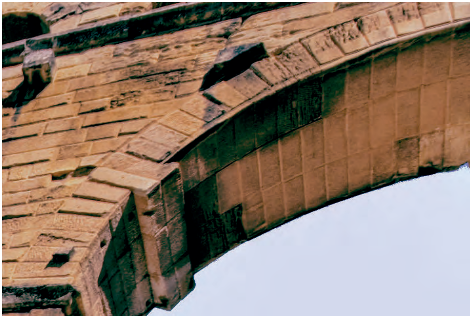
Abb. 3.21: Pont du Gard (Provence), Detail der mittleren Bogenreihe (W. Osthus).
