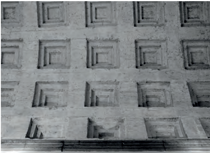
Abb. 2.76: Palazzo Venezia, Rom, Vestibül, ca. 1466, Detail der Gusstone mit Kassettierungen (Foto: H. Schlimme).
