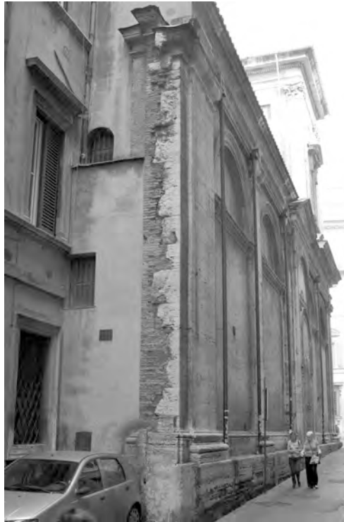
Abb. 2.62: San Luigi dei Francesi, Rom, ab 1530, unvollendete Flanke mit Verzahnung zwischen Ziegelsteinmauer und Travertinfassade (Foto: H. Schlimme).
