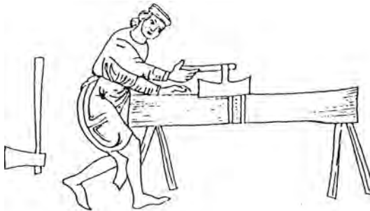
Abb. 1.11: Zimmermann beschlägt einen Balken, 1248 (italienisches Stundenbuch, Bologna, Archivio di Stato).
