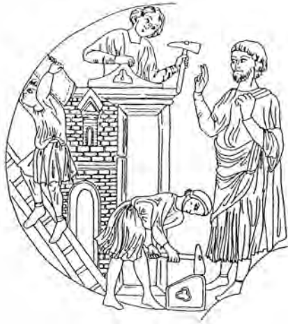
Abb. 1.10: Bauherr auf der Baustelle, Laufschräge, Spitzfläche, Lotwaage, um 1210/15 (Glasmalerei im Chor der Kathedrale von Laon).
