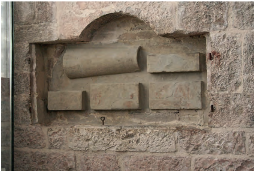
Abb. 2.2: Ziegel- und Dachziegelmodelle am Rathaus von Gubbio (Foto: M. Quast).
