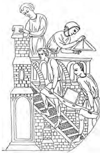
Abb. 1.6: Baustelle mit Laufschräge, Trage, Lotwaage, um 1225 (Glasmalerei im nordöstl. Chorumgang der Kathedrale von Chartres).
