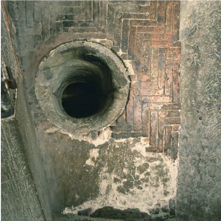
Abb. 6.7: Kuppel von Santa Maria del Fiore, Schlussring, Kappe 1 (Westen), Blick durch eine Lichtöffnung aus Macignostein in den Raum zwischen den zwei Schalen (Foto: ECHO, Rullo 12 Foto 02).
