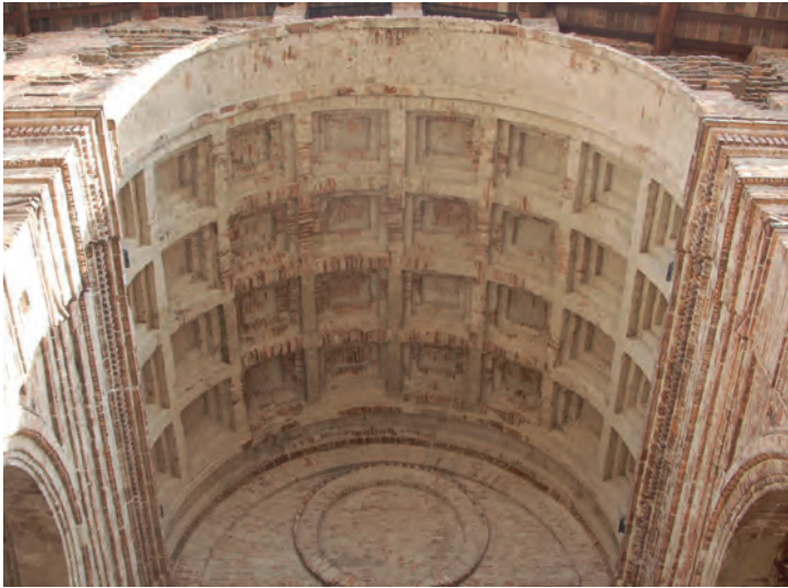
Abb. 2.75: Sant'Andrea, Mantua, ab 1470, kassettierte Tonne im seitlichen Vestibül, ausgeführt 1530–1565 (Foto: H. Schlimme).
