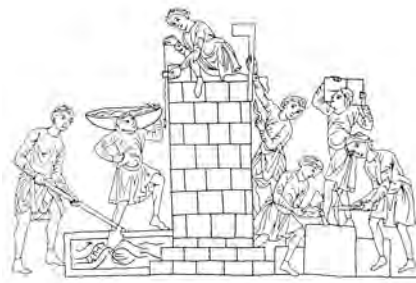
Abb. 1.8: Turmbau zu Babel, Steinmetzen mit Lot, Richtscheit, Doppelspitze, Schlageisen und Klöpfel sowie Mörtelmischer mit Mischhacke (Herrad von Landsberg, Hortus deliciarum , fol. 27, verbrannt).
