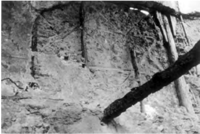
Abb. 2.18: Innenwand eines im Abbruch begriffenen Hauses am Corso Italia in Filadelfia, Detail: „x“-förmige Ausfachung der Wand; hier sichtbar die Abdrücke der herabgefallenen Holzbalken (Foto: S. Tobriner).
