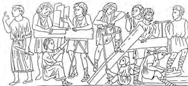
Abb. 1.14: Zimmerleute mit Säge, Bohrer, Hobel, Breitbeil und Rahmensäge, um 1220/1300 (Mosaik in der westlichen Vorhalle von San Marco in Venedig).
