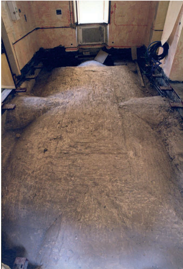
Abb. 2.77: Palazzo Zuccari, 1592–1610, volta a schifo mit vier Lunetten über dem Vestibül (Foto: Enrico Da Gai).
